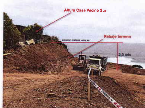
Excavaciones Lado Sur, 5,5 mts bajo el Terreno natural
