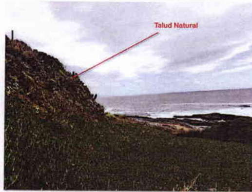
Foto Talud Terreno Natural, vista hacia Ramba
