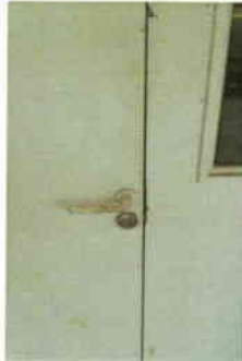
PROYECTO 1 ITEM INSTALACIÓN DE CHAPAS NUEVAS
