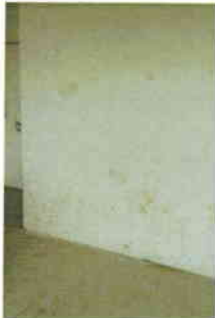
PROYECTO 1 ITEM PINTURA MUROS EXTERIORES
