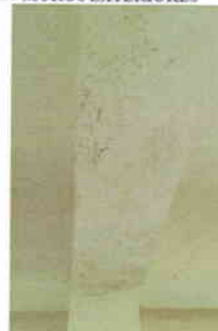
PROYECTO 1 ITEM PINTURA MUROS EXTERIORES
