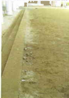
PROYECTO 1 ITEM CONSTRUCCION DE CANALETA ULMA
