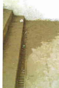
PROYECTO 1 ITEM MEJORAMIENTO CANALETA EXISTENTE
