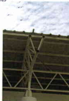
PROYECTO 1 ITEM TERMINACIÓN ESTRUCTURA Y CANALES AGUAS LLUVIAS
