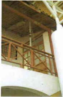
PROYECTO 1 ITEM CAMBIAR VIGA ESTRUCTURAL
