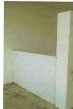
PROYECTO 1 ITEM INSTALACION DE MALLA CAJA ESCALA
