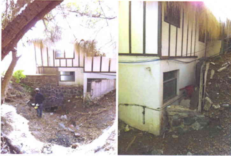
Imagen muro sur
